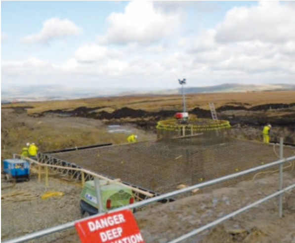
Bau des Windpark Hyndburn in Großbritannien (24,6 MW)
