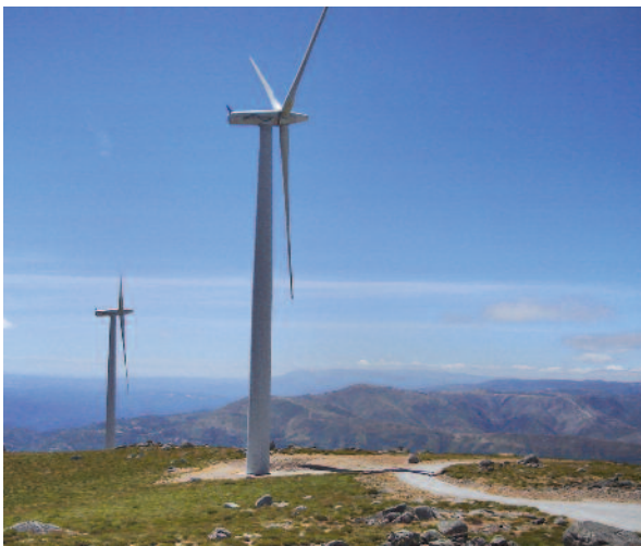
Windpark Montemuro im Norden von Portugal
