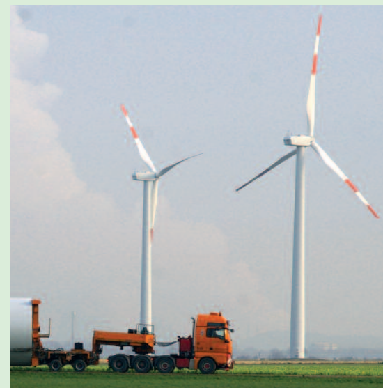
Seit Anfang des Jahres liefert der Windpark Titz klimaneutralen Strom für NRW.
