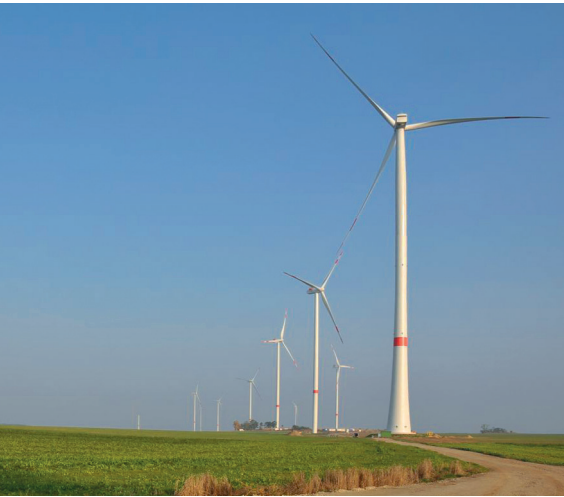
139 Meter beträgt die Nabenhöhe der neuen Anlagen, der Rotor durchmisst 120 Meter.
